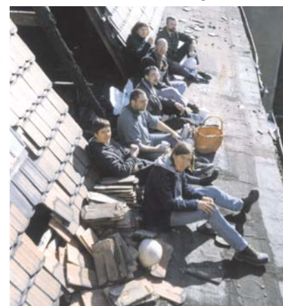
Arbeitseinsatz in der Barfüßer Straße 8.
